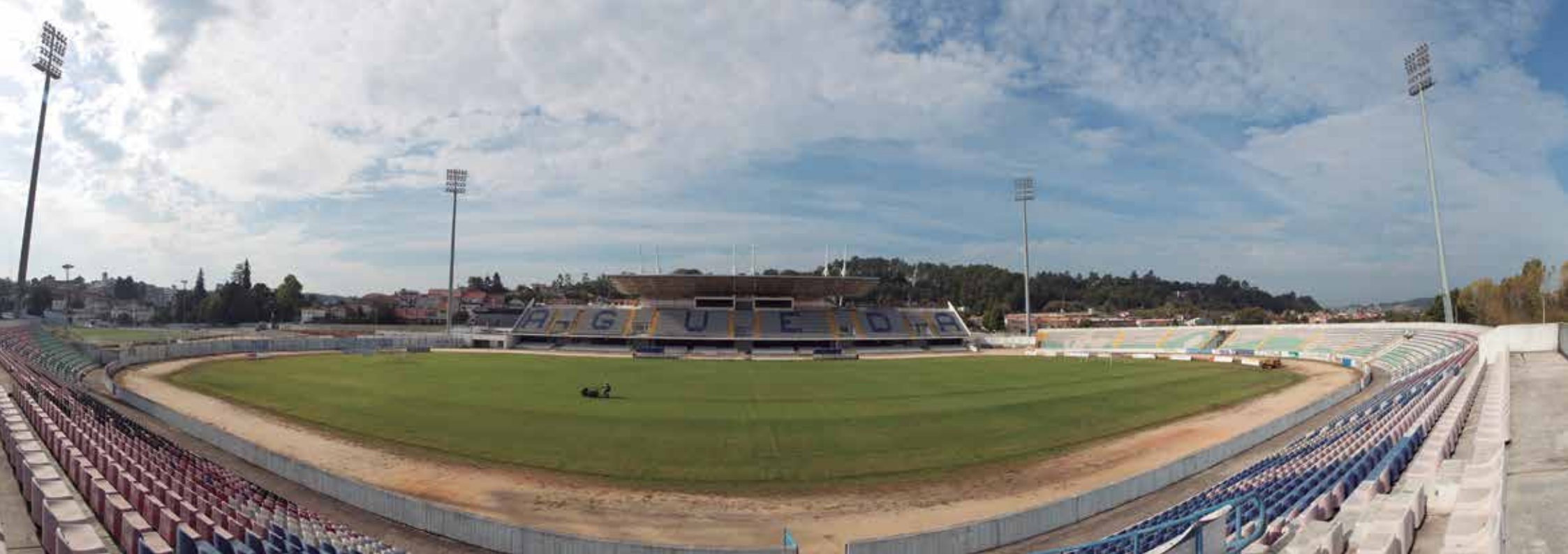
Estádio Municipal de Águeda
